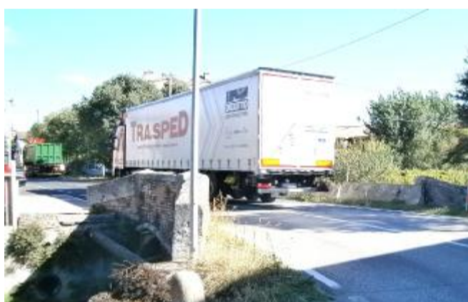
Il ponte sulla fossa Grimani ad Erbè percorso di continuo dai tir
