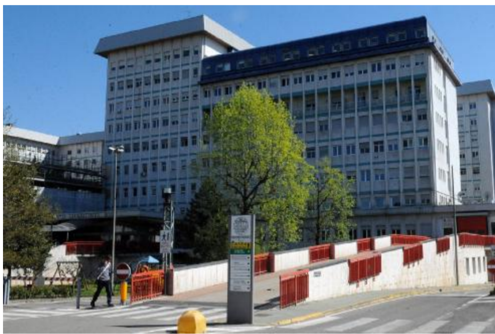
Il policlinico di Borgo Roma dove ha sede il reparto oncologico pediatrico
